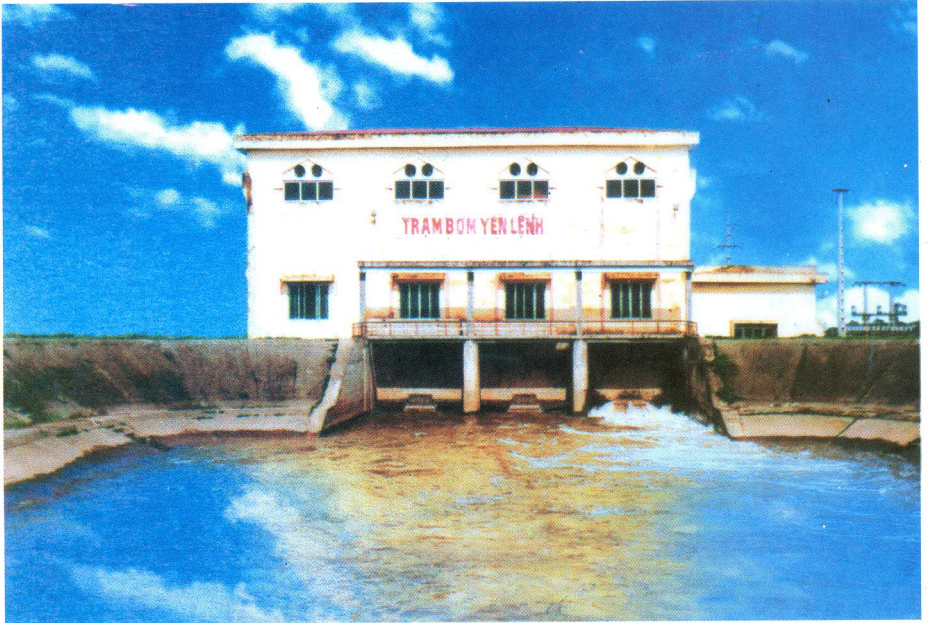
Trạm bơm Yên Lệnh, huyện Duy Tiên, công suất 75.000m 3 /h, khởi công xây dựng năm 1997
