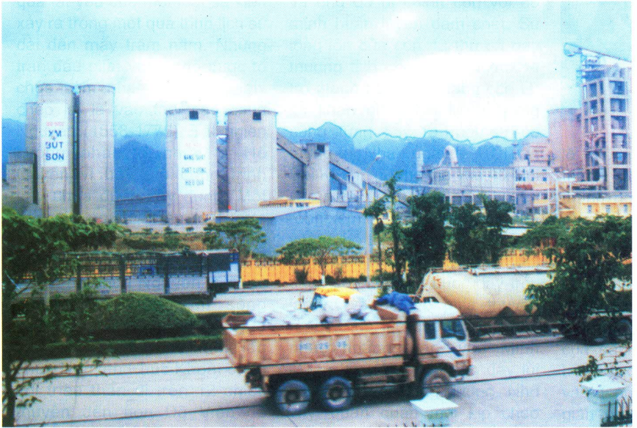
Dây chuyền I Công ty xi măng Bút Sơn, công suất 1,4 triệu tấn/năm, khởi công xây dựng năm 1995, khánh thành và đi vào hoạt động năm 1997
